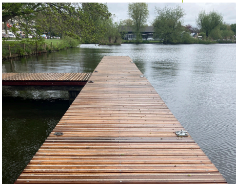
Vlonder aan de Bergsche Voorplas in Rotterdam gemaakt van conservation timber van de houtsoort Pucté ( Bucida buceros ) uit de Selva Maya. (Foto: Gemeente Rotterdam)
