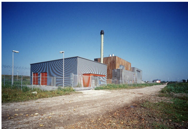
Figuur 8 Biomassaverbrandingsinstallatie in Lelystad (1,7 MW e )
