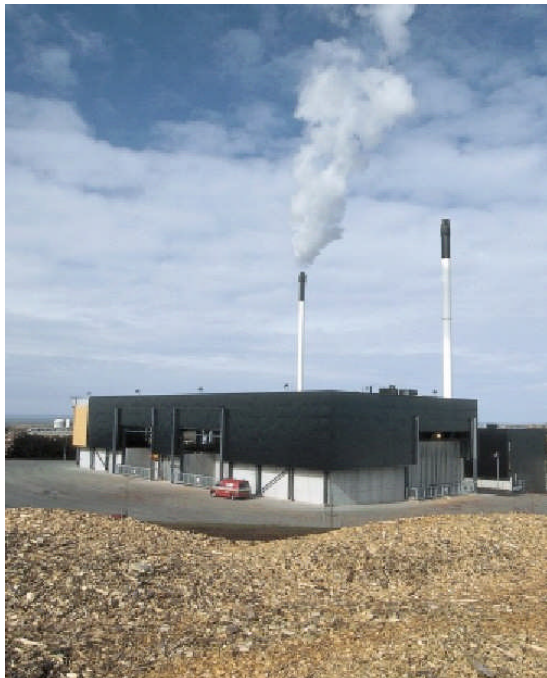
Figuur 9 Biomassaverbrandingsinstallatie in Denemarken (4,7 MWe)
