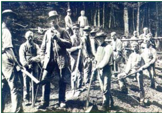
Aménagement d'un chemin à travers une forêt au début du vingtième siècle. Jusqu'à dans les années cinquante, l'aménagement des chemins était encore souvent réalisé à la main.
